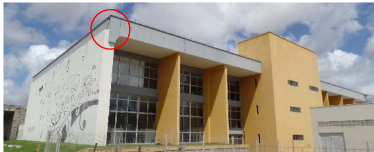
Figura 13 – Edificação construída em 2011: sombreamento das aberturas e alusão nas platibandas ao formato das vigas-calhas do prédio de 1975/79.
