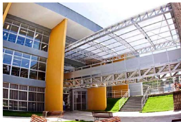
Figura 4 – Passarela de ligação entre a primeira edificação da BCZM e seu anexo. Neste caso, a passarela assume papel de elemento nexa entre as edificações.
