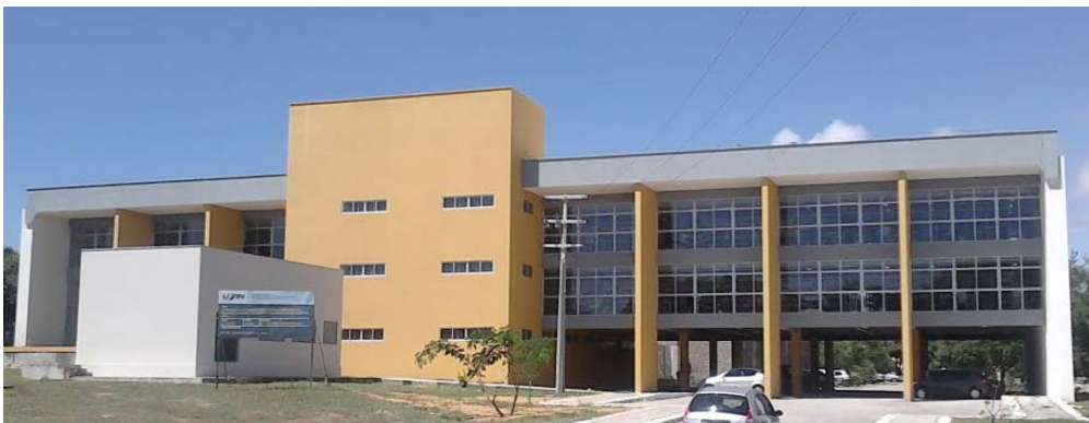
Figura 8 –Edificação construída em 2011: volume único com maior expressão vertical.
