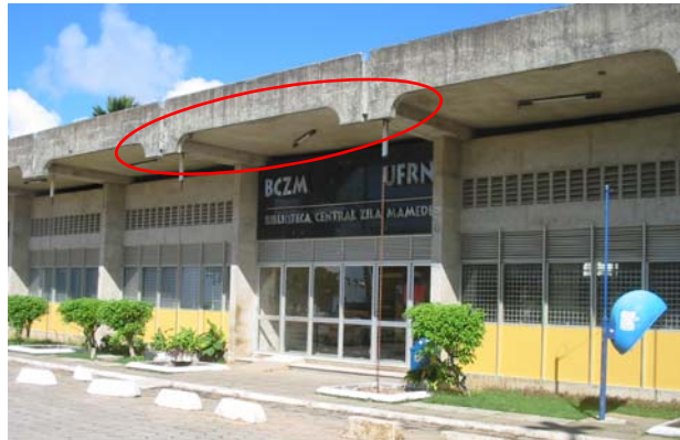
Figura 12 – Edificação construída em 1975/79: sombreamento das aberturas e vigas-calhas.
