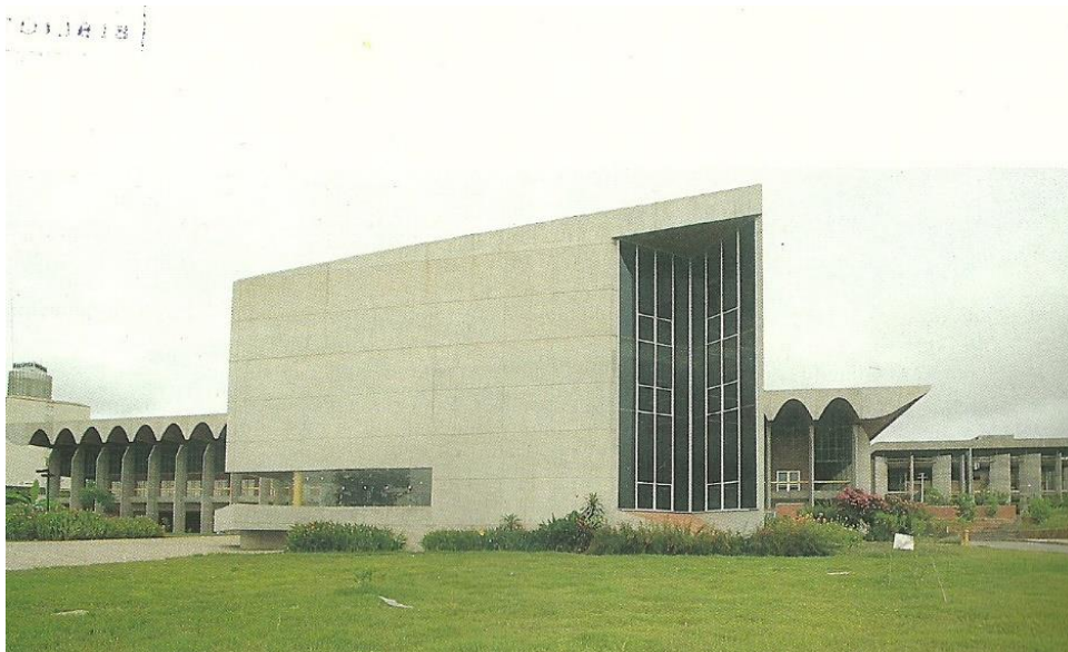
Figura 1: - Em primeiro plano Plenário, em segundo outro volume da Assembleia e ao fundo, a esquerda, o edifício do Tribunal de Justiça. Fotografia de Acácio Gil Borsoi.
