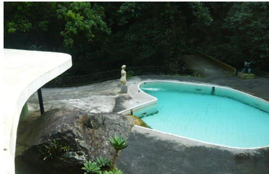
Imagen 6. Oscar Niemeyer, Casa das Canoas. Vista desde la cubierta. Fotografía: Luca Bullaro, 2011.
