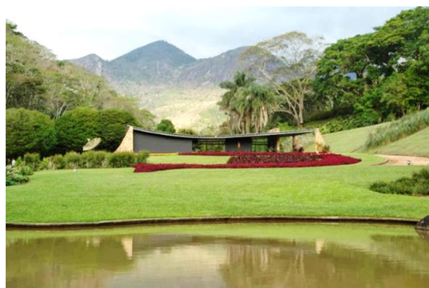
Imagen 5. La Casa Canavelas: la arquitectura y el paisajismo reinterpretan las reglas biológicas y geológicas del entorno. Fuente: Leonardo Finotti
