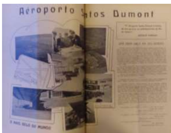
Figura 2 – Reportagem sobre o Aeroporto Santos Dumont em obras
