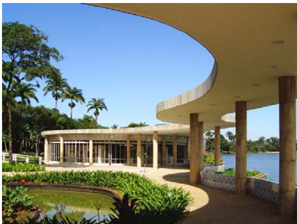
Figura 2a – Marquise com teto plano e vigamento invertido na Casa do Baile. Oscar Niemeyer, Arquitetura. Albino Froufe, Cálculo Estrutural.
