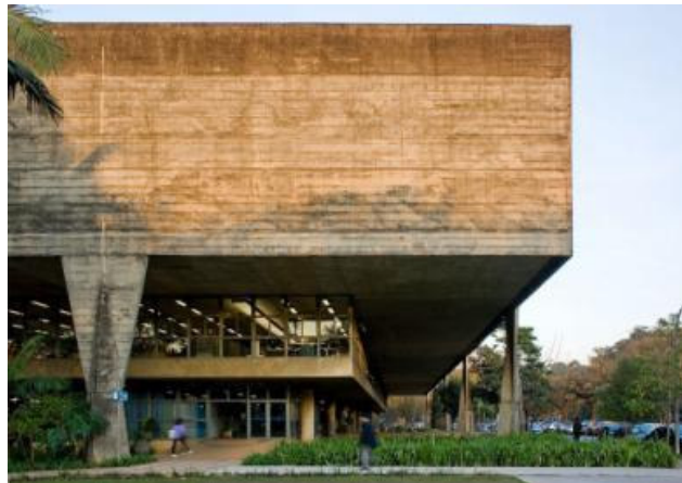
Figura 1 – Edifício da FAU-USP
