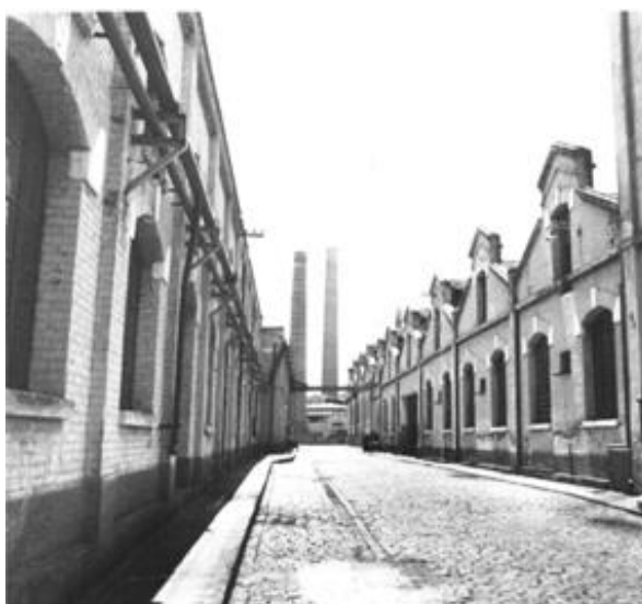
Figura 3 – Arquitetura industrial típica da década de 1920. Vista interna do conjunto das IRMF na Água Branca.
