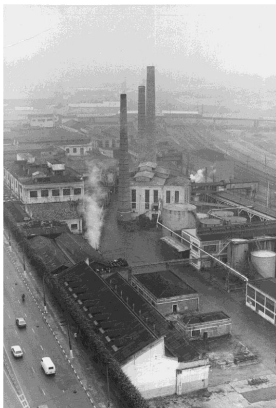
Figura 6 – Vista do conjunto das IRMF na Água Branca.
