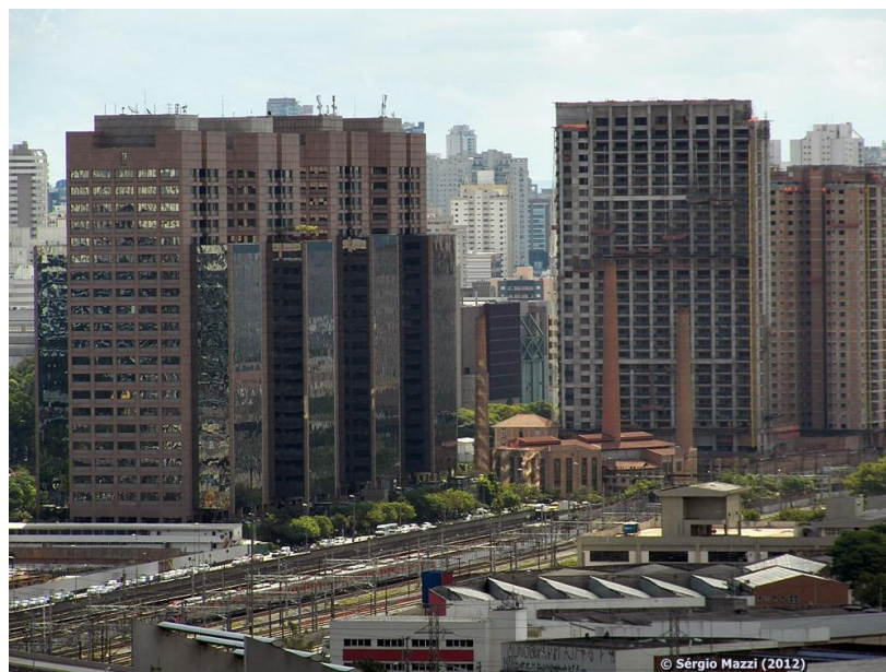
Figura 7 – Vista da Casa das Caldeiras atualmente
