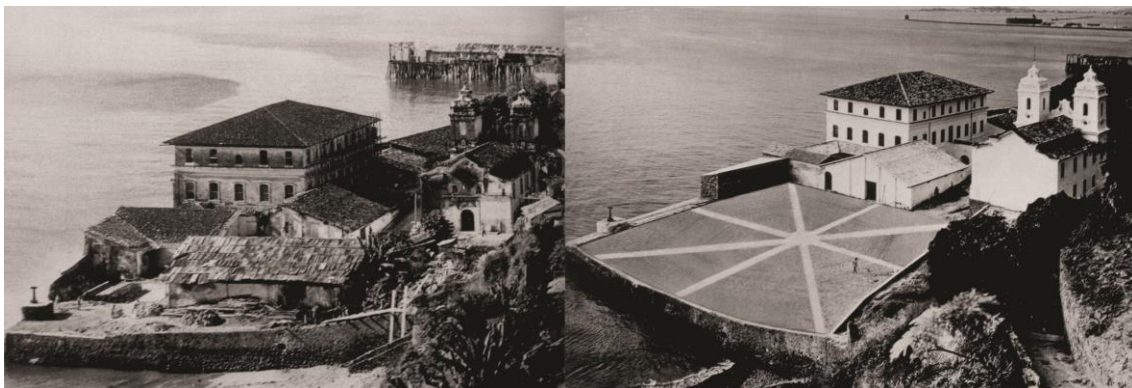
Figura 2 - Conjunto arquitetônico do Unhão antes e depois do restauro.
